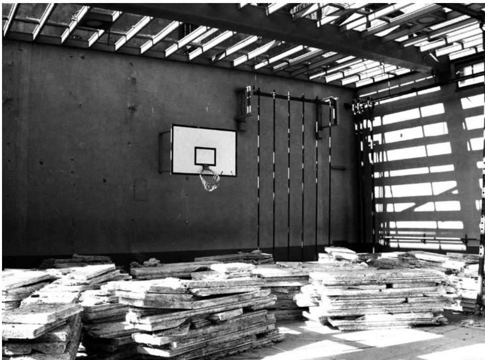
Photo: Bovet Jeker architectes sàrl / Maître d'ouvrage de la nouvelle salle de sport de Beaulieu: Etat de Vaud - SIPAL / DF-IC
