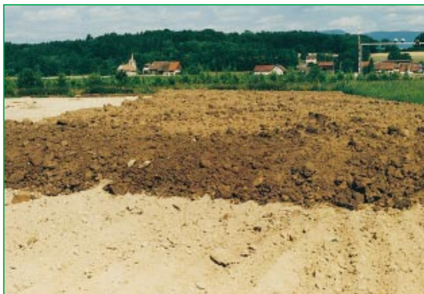
Reconstitution des sols agricoles sur un remblai morainique aux «Aventuries» à Payerne. Au premier plan le remblai sous-solé, derrière la terre végétale déposée sur une épaisseur de 70 cm.
